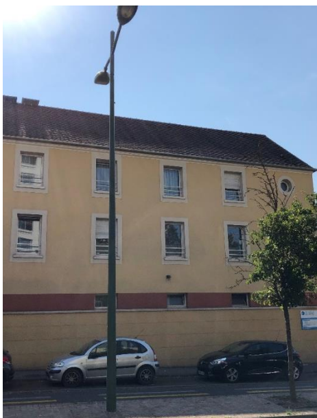
Site P7_1 : 29 avenue du Général de Gaulle à Saint-Ouen-L'Aumône.
